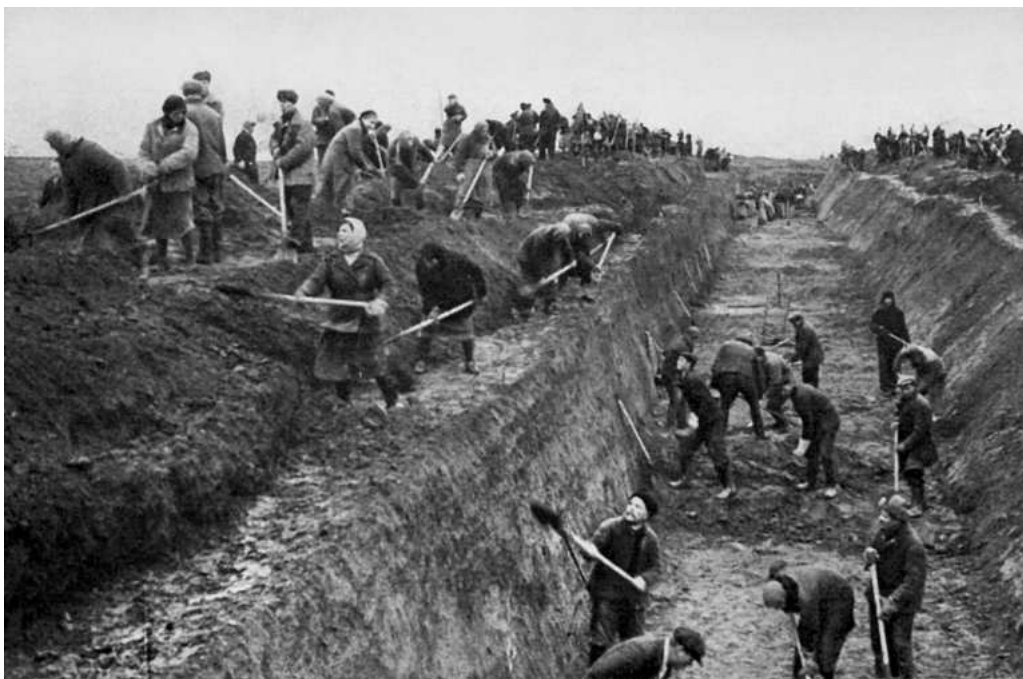
Строительство оборонительных сооружений под Москвой. Осень 1941 г.
