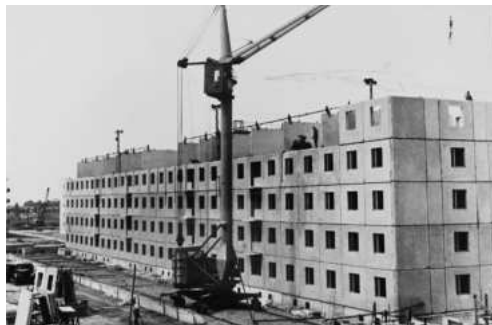
Строительство пятиэтажного жилого дома. Город Волжский
