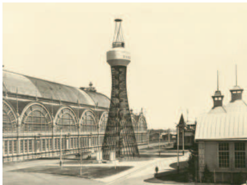
Гиперboloидная башня. Инженер В. Г. Шухов
