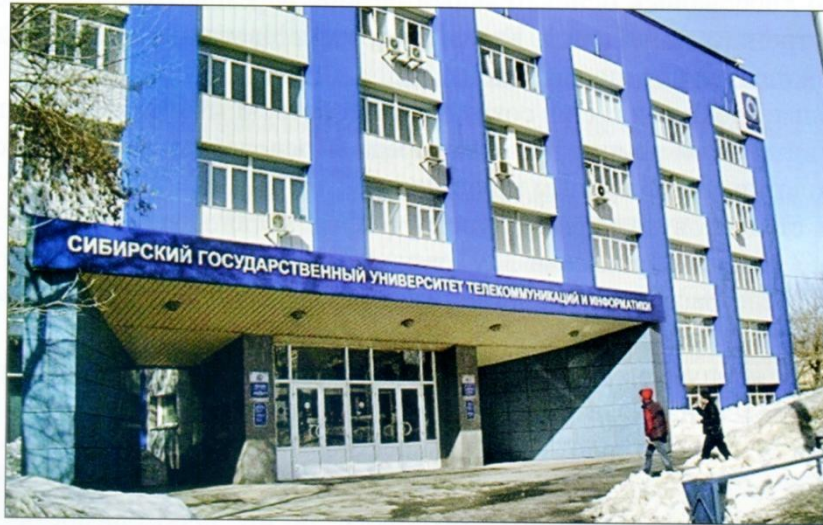
Новый корпус СибГУТИ
