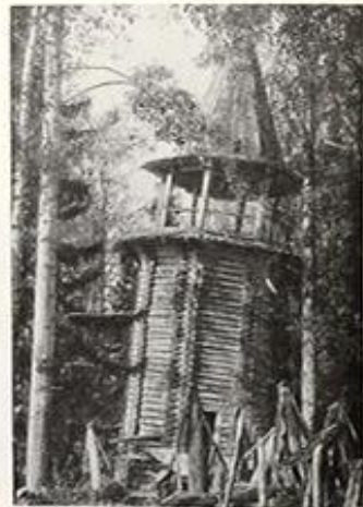
3. Топова башня, Прионежский район Кировской области ССР, Шумихинский район
